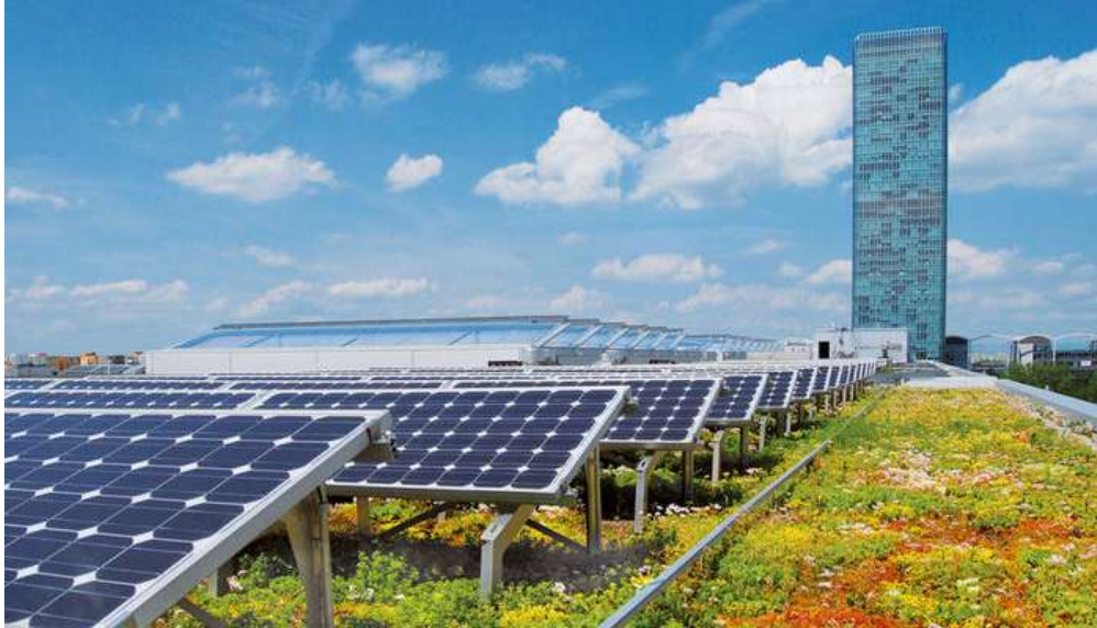
Figuur 66: Combinatie van een groendak en zonnepanelen. © ArchiexpO
