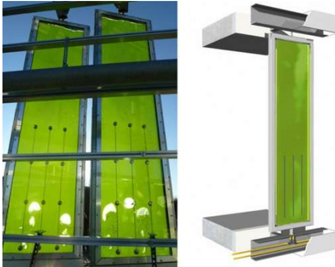
Figuur 84: Zonneschermen van algen rond het BIQ gebouw © Spitterwerk Architects
