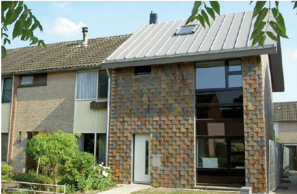
Figuur 87: Proefwoning in de woonwijk “De Kroeven” in het Nederlandse Roosendaal. De renovatie van van F/G naar A++ woningen neemt slechts vijf dagen in beslag dankzij de doorgedreven ketensamenwerking tussen alle partners (meer info in brochure passief renoveren De Kroeven Roosendaal)
