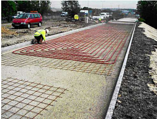
Figuur 86: Aanleg van een zonnewegcollector in Toddington, UK © ICAX
